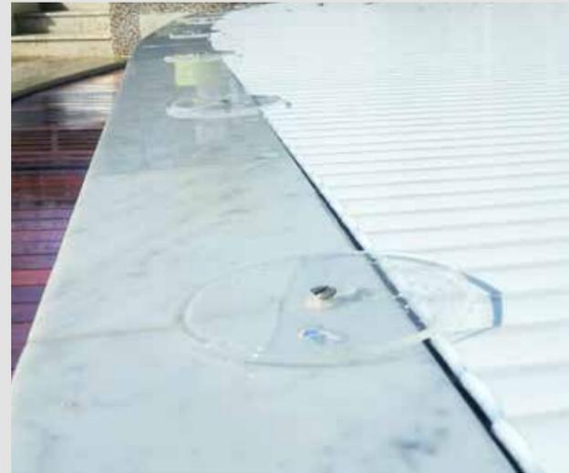
La mise en sécurité du bassin nécessite la mise en place d'un système dit d'anti-soulèvements. Celui-ci est composé de pitons escamotables et de disques de plexiglas transparents. Ce dispositif permet de maintenir le volet en place en cas de forts vents et d'éviter qu'un enfant de moins de 5 ans puisse passer en dessous du tablier. Le système est obligatoire pour que le volet soit conforme à la norme NF p 90-308.
