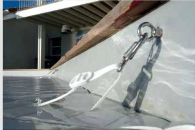
Un système de fixation des lames en bout de bassin est obligatoire. Il devra être impérativement mis en place à chaque fermeture du volet et déverrouillé avant chaque ouverture.
